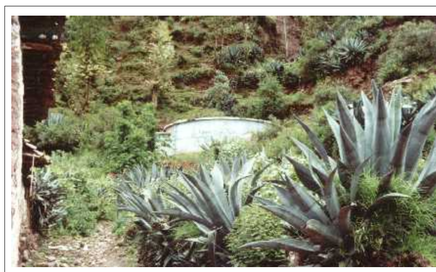
FOTO N° 14: Reservorio de Agua Potable
