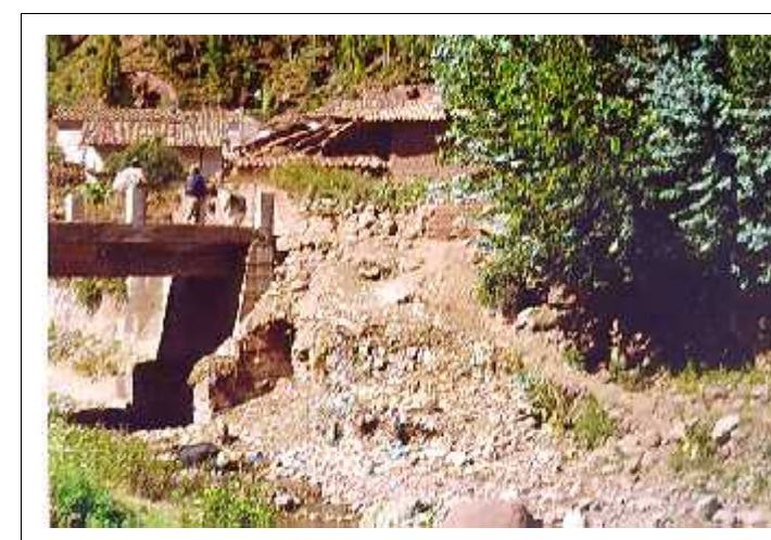
FOTO N° 08: BOTADERO DE BASURA
